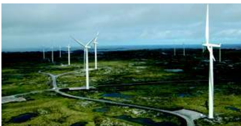
Smøla Wind Farm in Møre og Romsdal.
